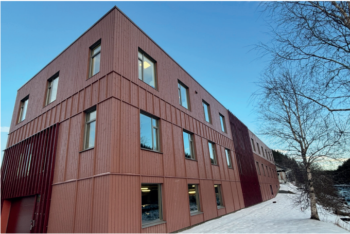
Det nye helsehuset ligger kloss inntil Stordalselva i Åfjord sentrum.
